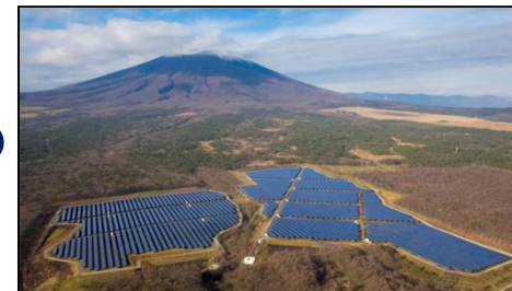
滝沢メガソーラー（約20.8MW）
