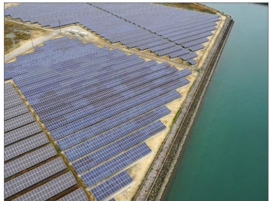
写真 1:愛媛県吉海港第 1 太陽光発電所
