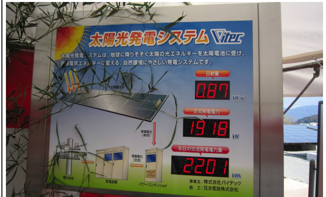
運転開始より約2,000kWの発電が確認
