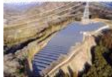
沢渡温泉第2太陽光発電所
