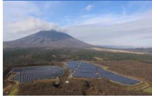
岩手県滝沢 20.8MW
