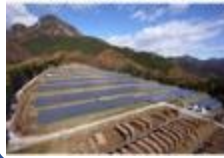
沢渡温泉第1太陽光発電所
