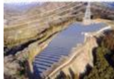
沢庵温泉第2太陽光発電所
