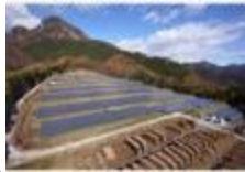
沢庵温泉第1太陽光発電所
